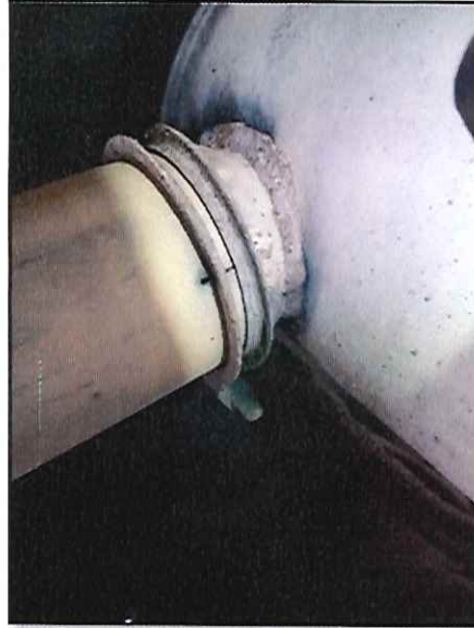
Local: Chassi Item # 36: silencioso do escape quebrado no tubo de saída. Status: corrigido .
