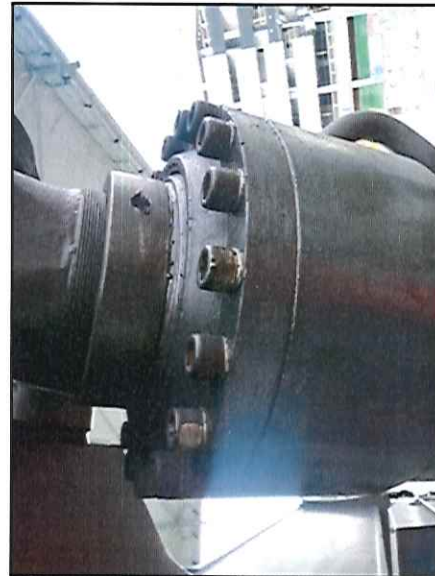
Local: Lança Item # 42: vazamento de óleo pelo cilindro de elevação da lança, lado direito. Status: corrigido .
