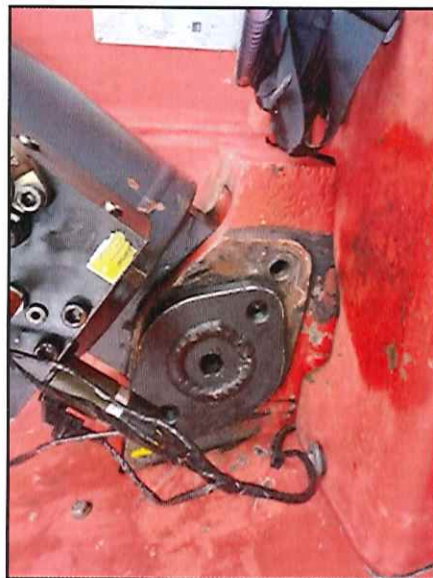
Local: Lança Item # 42: pequeno vazamento de óleo no bloco hidráulico do cilindro de elevação, lado esquerdo. Status: corrigido .
